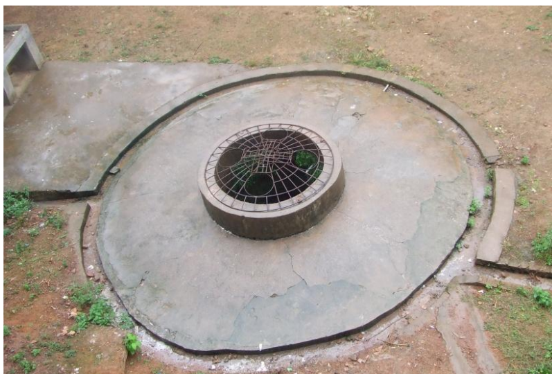
图 11 安装防护罩的水井
